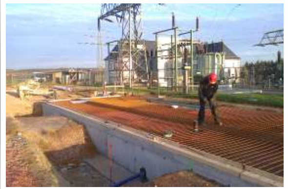
Umspannwerke Zschopau, Oederan, Glauchau
